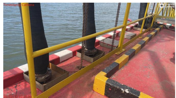
ภาพที่ 2-5 ถังรองน้ำมันที่อาจหกรั่วไหลจากการถอดท่อและข้อต่อในการขนถ่ายน้ำมันที่ท่าเรือ
